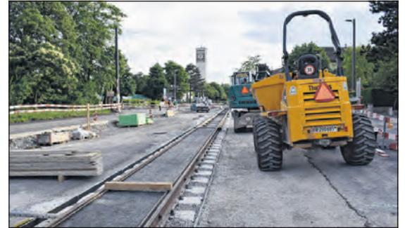
Auf der aktuellen Etappe werden 2900 Meter Gleise, 750 Spurstangen und 4500 Schienenanker verbaut.
