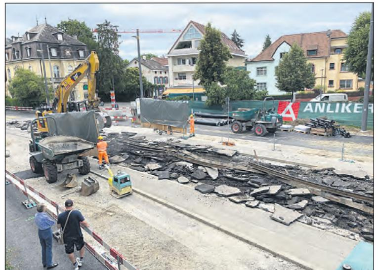
Das Herausreissen der alten Tramgleise und des Asphalts war lärm- und staubintensiv.
