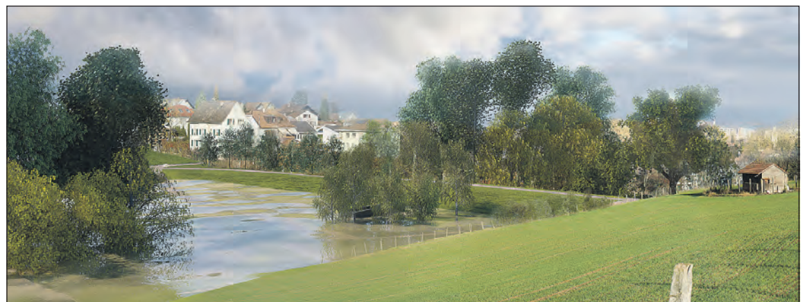
Ein Rückhaltebecken soll Hochwasser davon abhalten, das Dorf zu überschwemmen. Zur Entlastung des Beckens wird das Wasser via Einlaufschacht kontrolliert in den Bach abgeleitet werden. Visualisierung Kanton BL
