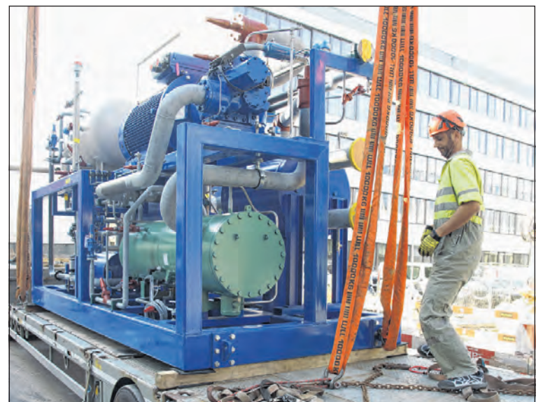
Ein Arbeiter nimmt die Wärmepumpe in Empfang. Diese spielt bei der Verteilung der Wärmeenergie auf dem Baselink-Areal eine zentrale Rolle.
