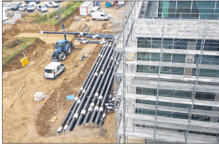
Noch sind die sieben Leitungsrohre (je zwei für Wärme, Kälte und die Erdsondenfelder sowie eines als Reserve) auf dem Baselink-Areal sichtbar. Bald werden sie vollständig mit Erde bedeckt sein.
