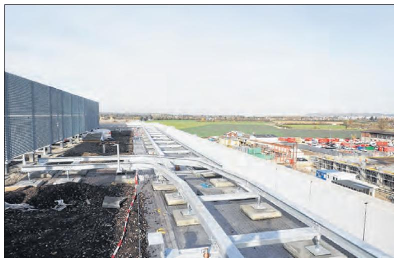
Bei diesen Gleisen handelt es sich um die Verankerung für die Vorrichtung, mit der die 20 Meter hohe Fassadenbegrünung gepflegt werden kann.
