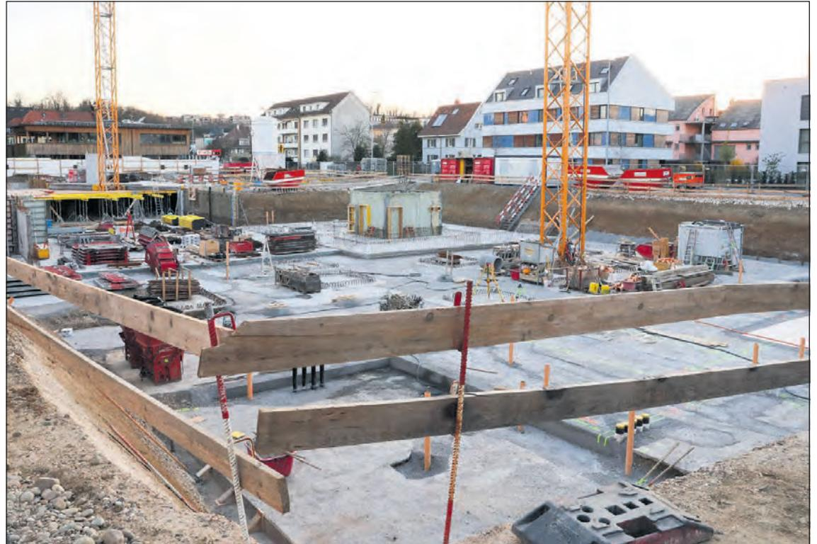
Noch wird für das Untergeschoss betoniert und gemauert, aber ab Juli werden die fünf Gebäude im Vollholzbau entstehen.
