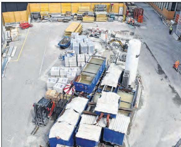
Vom Dach des Bau 4 schweift der Blick unter anderem über die Reinigungsanlage fürs Bauwasser.
