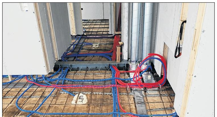
Auf den Holzboden werden verschiedene Leitungen (Lüftung, Strom) verlegt, bevor der Flüssigbeton darauf gegossen wird. Foto zVg
