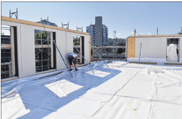
Um die Holzkonstruktion vor Regen zu schützen, muss sie bis zum Abschluss der Aufrichtung immer wieder mit Plastikplanen eingepackt werden.
