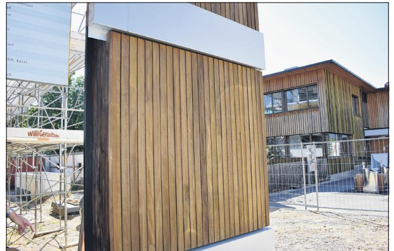
Am Rand der Baustelle steht ein Muster der Holzschalung, die das Äussere der Bauten zieren wird. Es handelt sich um druckimprägniertes Fichtenholz.
