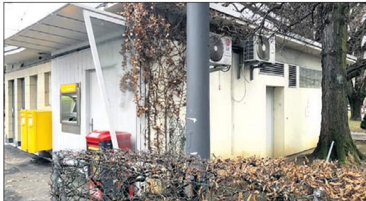
Das ehemalige Kioskgebäude auf dem Lindenplatz steht aktuell leer. Das dortige WC ist nicht in Betrieb.
