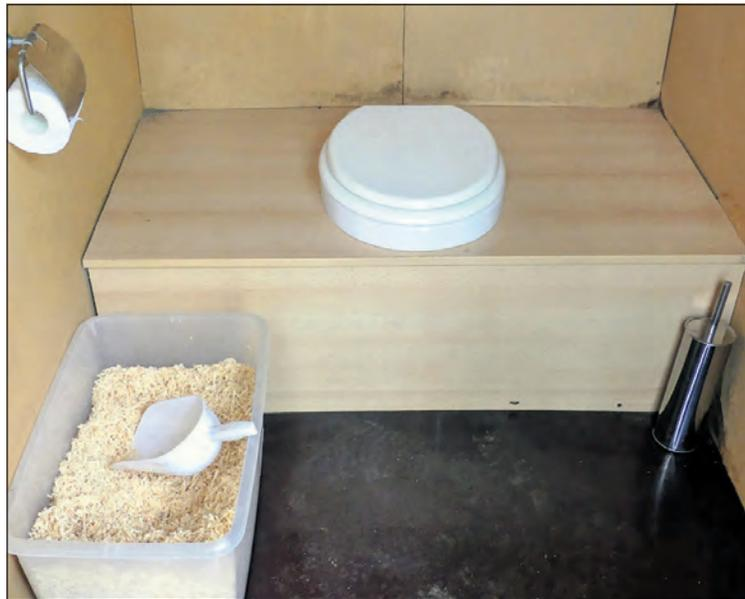
Komposttoiletten sind aus Holz gebaut und verwenden speziell behandeltes Sägemehl zur Kompostierung. Foto Adobe Stock
