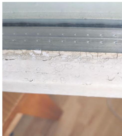
schwächt und beschädigt den Anstrich auf Dauer. Durch die feinen Risse dringt Feuchtigkeit in den darunterliegenden Untergrund ein und beginnt den Schutzanstrich abzulösen. Dies muss zwingend renoviert werden, um Bauteile auf Dauer zu schützen!
