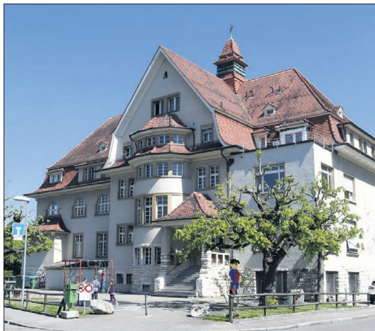
Bei der strategischen Führung der Schule sind auch Bau- und Infrastrukturprozesse relevant. In Allschwil ist der Schulraum aktuell knapp. Darum musste vor ein paar Jahren auch das Schulhaus Gartenstrasse wieder in Betrieb genommen werden.
