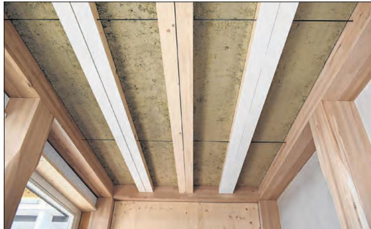
Die Decken des Hortus-Baus (im Bild ein Muster) werden aus Lehm aus der Baugrube und dem Leimental gefertigt, der in Holzrahmen gepresst wird.
