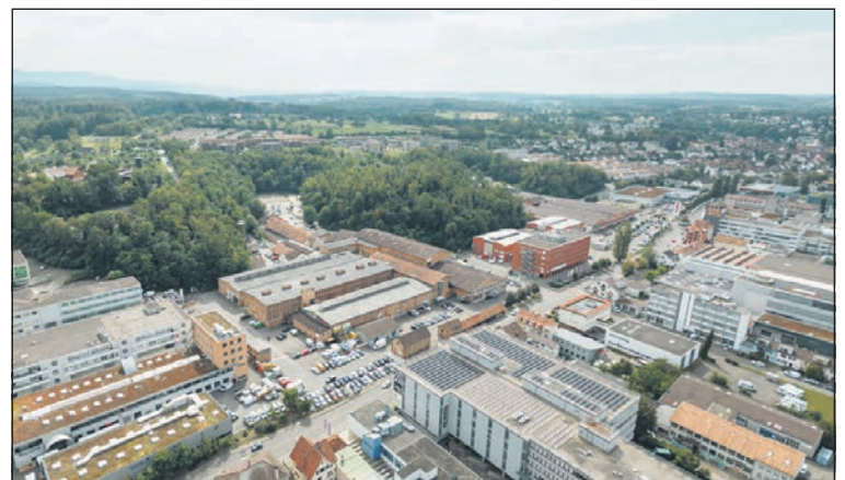
Seit 1975 werden die ehemaligen Ziegeleigebäude als Lagerhallen und Betriebsstätten für Gewerbe genutzt.
