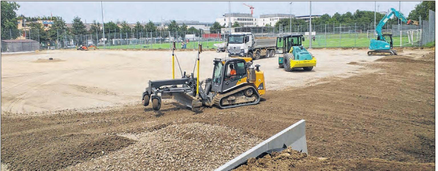
Unter einem Kunstrasen gehören verschiedene Materialschichten, die für Stabilität und eine optimale Drainage sorgen.
