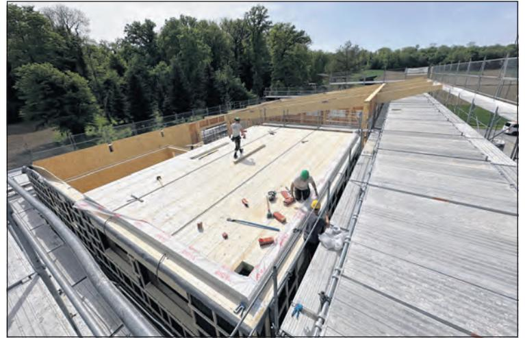
Während der Bauzeit gab es immer wieder eindrückliche Bilder – so etwa beim Einsetzen der Wandelemente (links) und bei der Dachkonstruktion, deren Träger eine stolze Länge von 24 Metern aufweisen.
