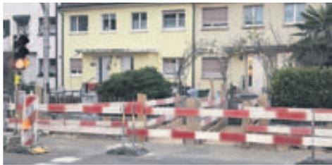
Die längs der Strasse verlaufenden Werkleitungen im Trottoirbereich werden saniert. Das erfordert lokal begrenzte Baugruben und Absperrungen. Ausserdem werden die Parkplätze aufgehoben. Die Parzellenzugänge bleiben weitgehend erhalten, jedoch nicht an der gewohnten Stelle.
