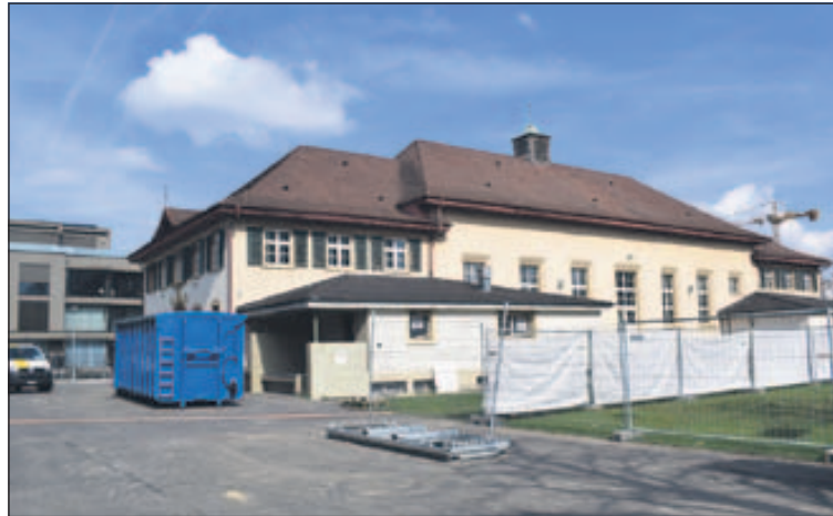
Bereits seit Anfang März sind erste Arbeiten bei der Turn- und Konzerthalle Gartenstrasse im Gange.
