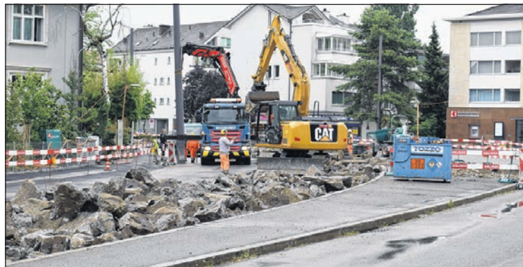
Das Trambäuschen bei der Ziegelei ist nicht mehr vorhanden. Die Geleise wurden rausgerissen, der Asphalt und Gleisbeton rausgebrochen.
