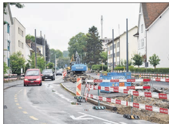
Der Verkehr Richtung Basel verläuft auf der Baslerstrasse. Der Verkehr Richtung Dorf wird via Maingasse und Baselmattweg umgeleitet.
