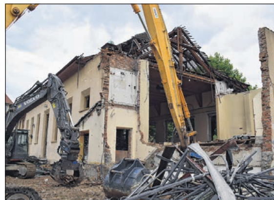
Die letzte Stunde der 1926 erbauten Turn- und Konzerthalle Gartenstrasse hat endgültig geschlagen. Sie verschwand in den letzten Tagen Stück für Stück.
