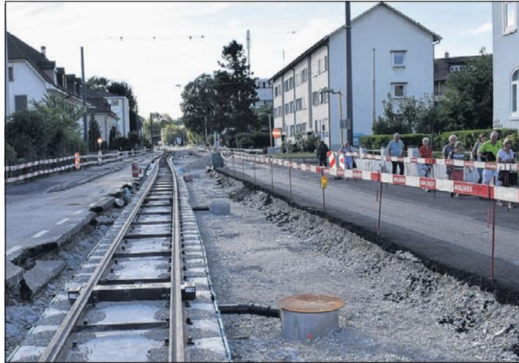
Nabe der Ziegelei sind die Scheinen bereits einbetoniert. Im Vordergrund ist ein Entwässerungskasten mit Rohr zum Schacht zu sehen. Fotos asc
